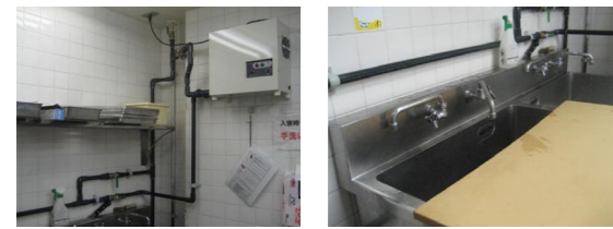
和食厨房に1台設置し、各シンクでオゾン水を使用しています。
